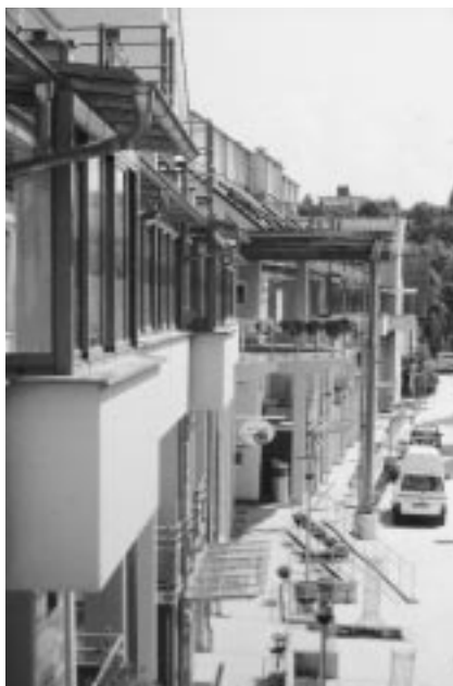
Abb. 3: Laubengänge und barrierefreie Erschließung im Kemptener Projekt
